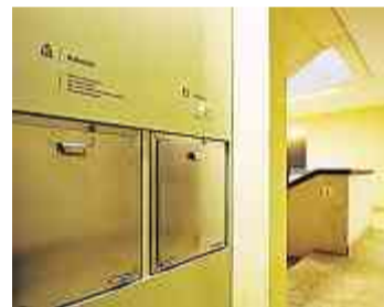
Einwurf-Türen für Kehricht und Wäsche im Treppenhaus.
