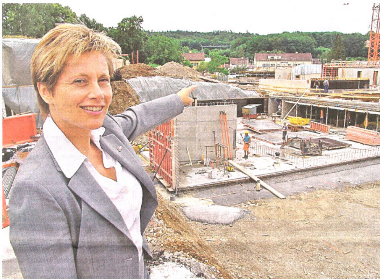
Elsbeth Aepli zeigt auf die Bauffläche. Im Hintergrund die Häuser B und C, die im Geschossbau stehen mit bereits eingebauten Nasszellen. Im Vordergrund der Aushub für Haus A.
